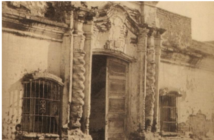
Imagen 1. La casa de la jura de la independencia antes de su reconstrucción en 1937
