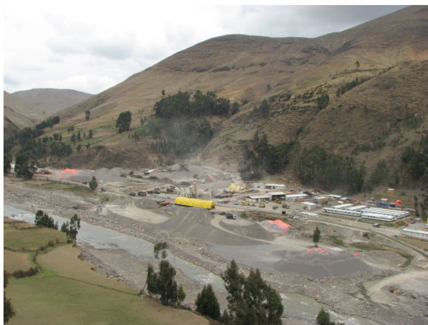
Imagen 6. Construcción de la carretera interoceánico, Ccarhuayo, Cusco. Foto de Leif Korsbaek, 2007.
